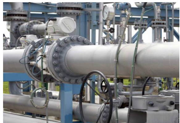
Gambar 8. Venturimeter pada pipa penyalur minyak
